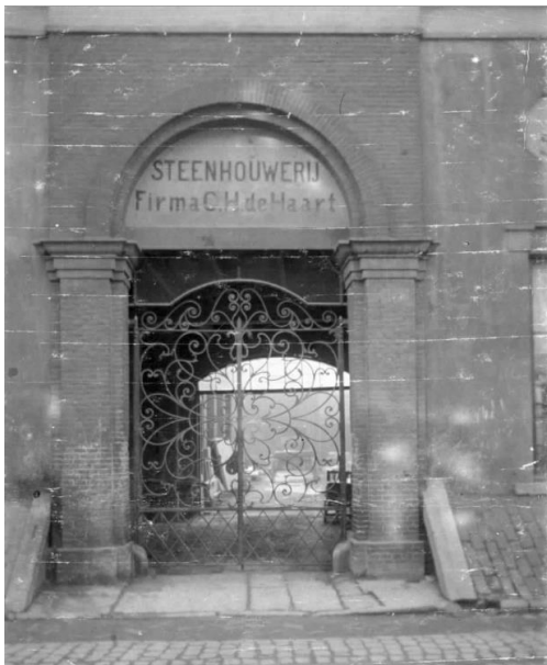
De poort van het pand Lange Nieuwstraat 119 in Utrecht.
